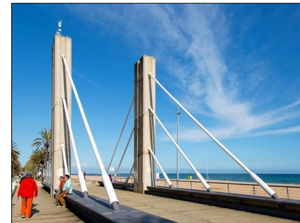
Pont de la Rirera de Capaspre
